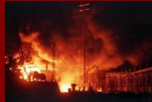
La centrale elettrica di Joumhour distrutta dagli israeliani il 8.2.2000
