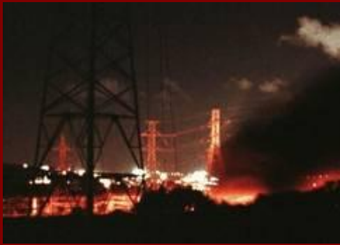
1999 Centrale elettrica libanese distrutta dagli israeliani
