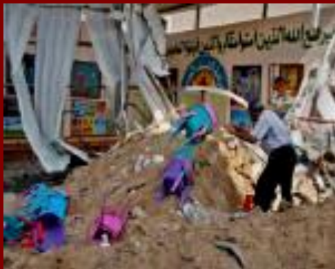
Scuole d'infanzia danneggiate
